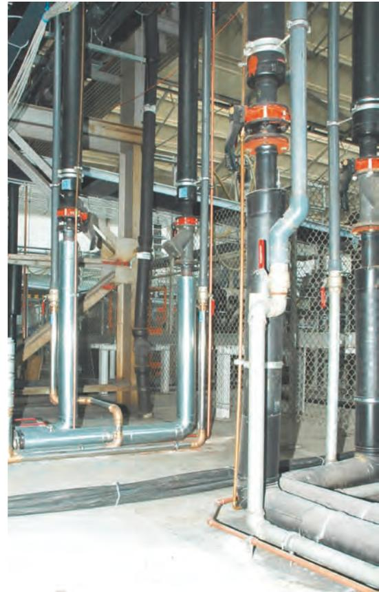
**Das Kühlnetz bietet Leistungsreserven und zusätzliche Anschlussmöglichkeiten an den relevanten Punkten der Produktionsfläche.**
