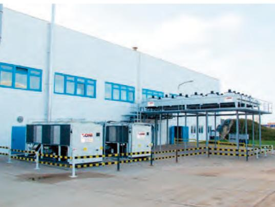
**Freikühler werden je nach Außentemperatur und Bedarf vom Kühlkreislauf der Spritzgießmaschinen genutzt oder in Kombination von Maschinen- und Formkühlung, um die Kältemaschinen zu entlasten.**
