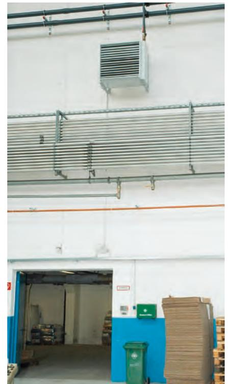
**Kleine aber sehr wirksame Luftheizungen werden automatisch aus der Wärmerückgewinnungsanlage im Rücklauf des Kühlkreislaufs gespeist.**
